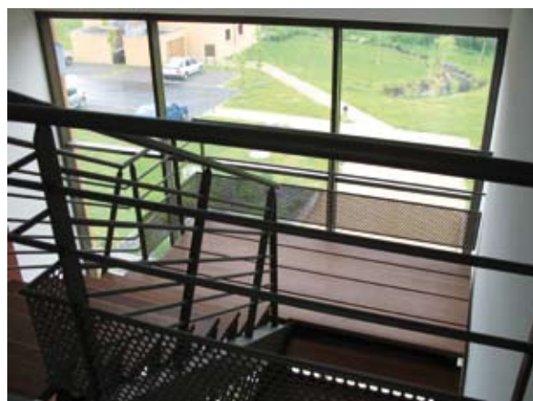
Privilégier la lumière naturelle dans les parties communes Opération de logements collectifs à Mordelles - Photo CETE Ouest
