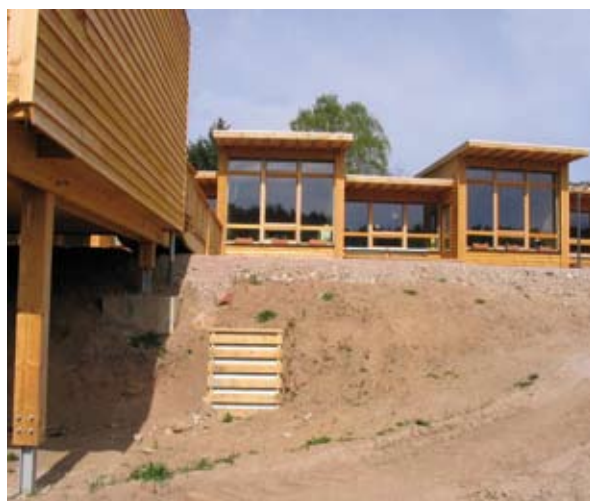
Entrée du puits canadien Opération Pôle éducatif de Thannenkirch - Photo CETE de l'Est
